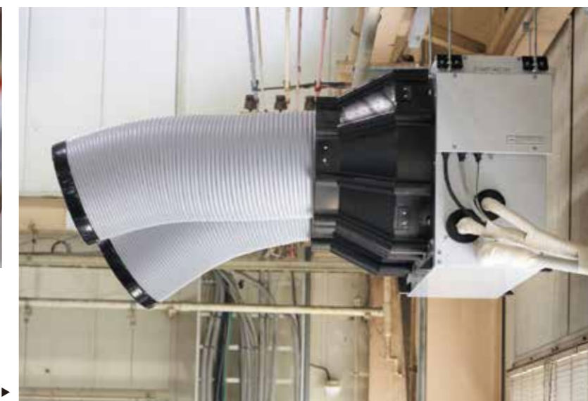
▶ 施設内の空きスペースを利用して設置できる天吊タイプを採用。配線・配管もスッキリ。
