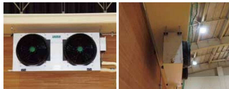
エリア空調機は天吊設置でキャットウォークの下に取付け
