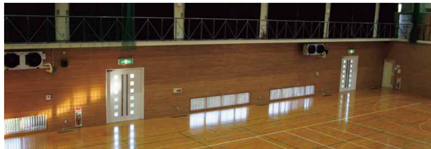
エリア空調機は天吊設置でキャットウォークの下に取付け
